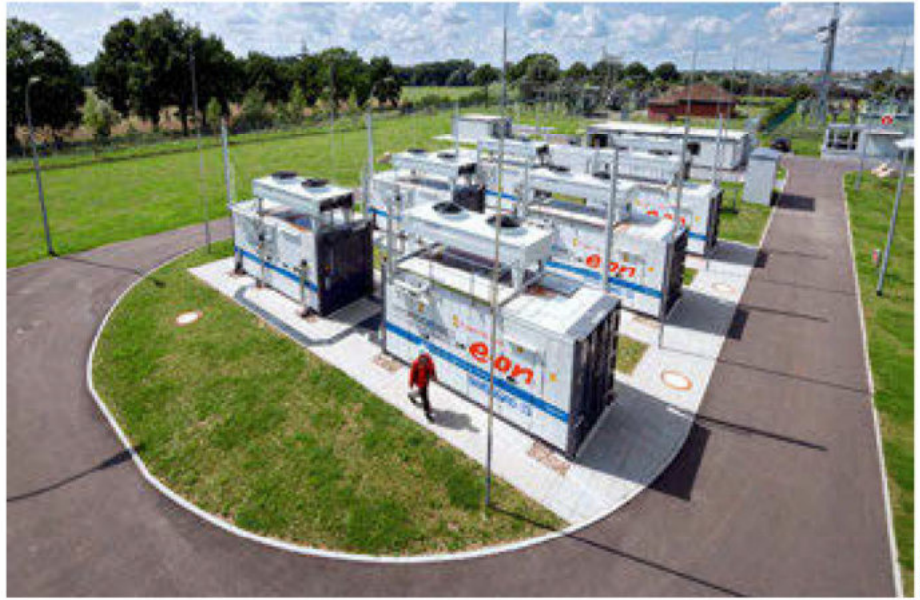
Windstrom zu Wasserstoff: Die Energieversorger Eon und Swissgas testen im Rahmen eines Power-to-Gas-Pilotprojekts in Ostdeutschland, wie sich Wasserstoff im Erdgasnetz speichern lässt.
